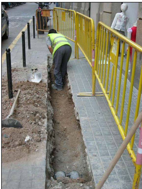
26. Procés de buidat manual de la rasa.
