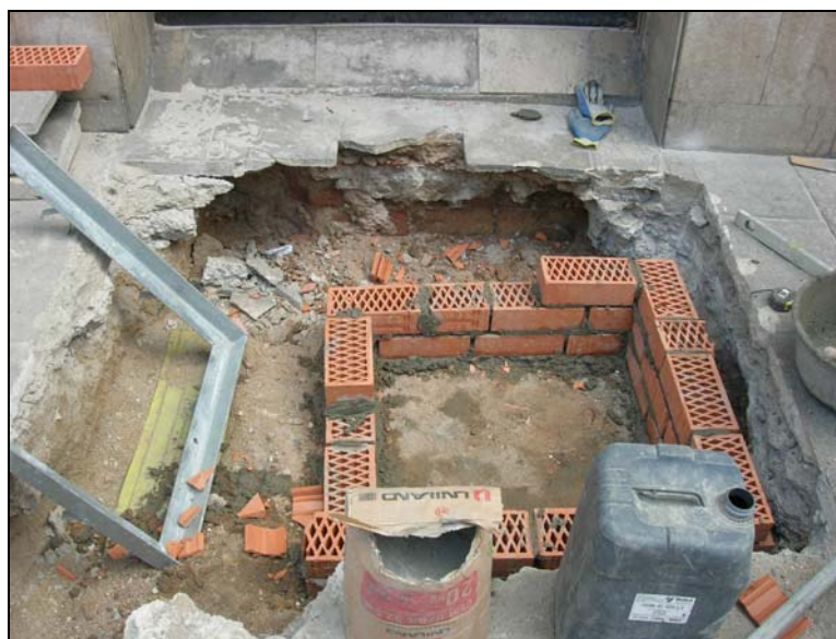
12. Construcció d'una arqueta d'obra.
