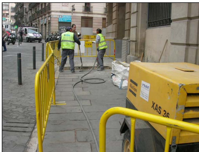
2. Inici dels treballs, cales de sondeig.
