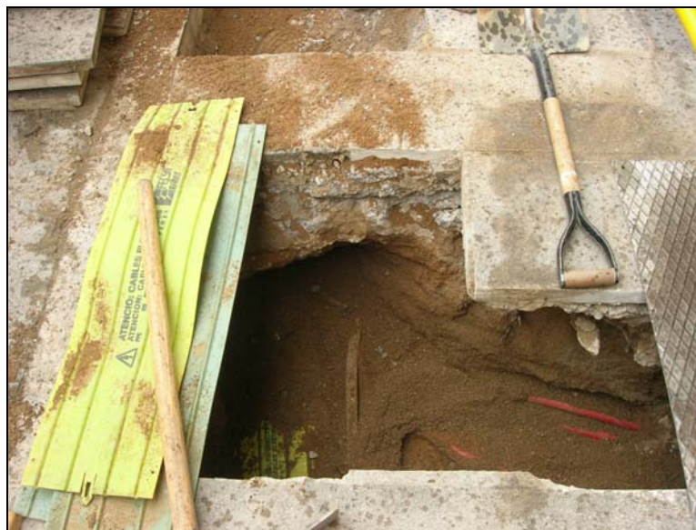
9. Inici de la rasa, serveis elèctrics.
