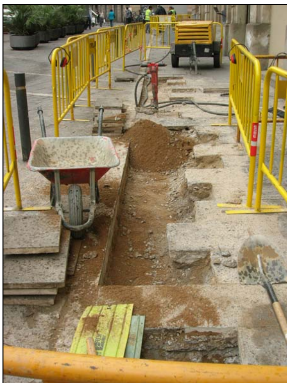
8. Inici dels treballs, extracció del paviment, davant Pl. St. Pere 4b.
