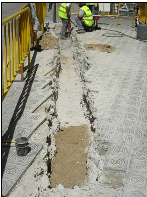
21. Obres de buidat davant el n°3 de la pl. St. Pere. No es documenta sediment, gran preparació de formigó per a llambordes, com a conseqüència de la circulació de vehicles en un moment anterior.
