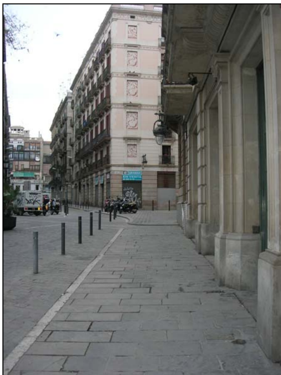
1. Vista del tram de vorera de la plaça de Sant Pere abans de l'inici dels treballs.
