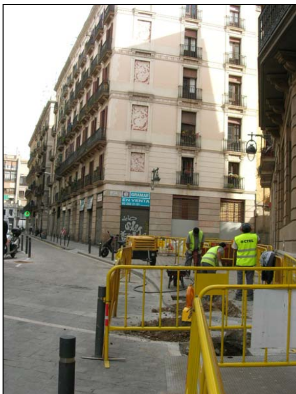
18. Vista de l'avenç dels treballs.
