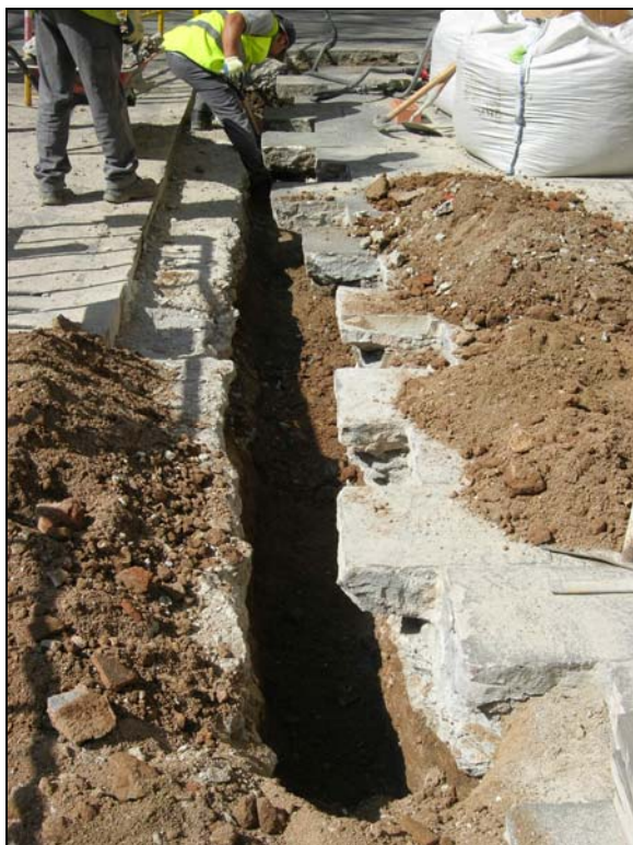
15. Buidat manual de la rasa.
