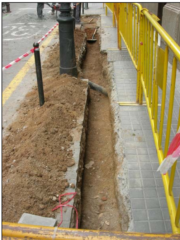
29. Tram final buidat.
