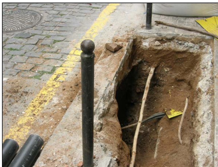
30. Serveis al final de la rasa, enllaç amb arqueta anterior.
