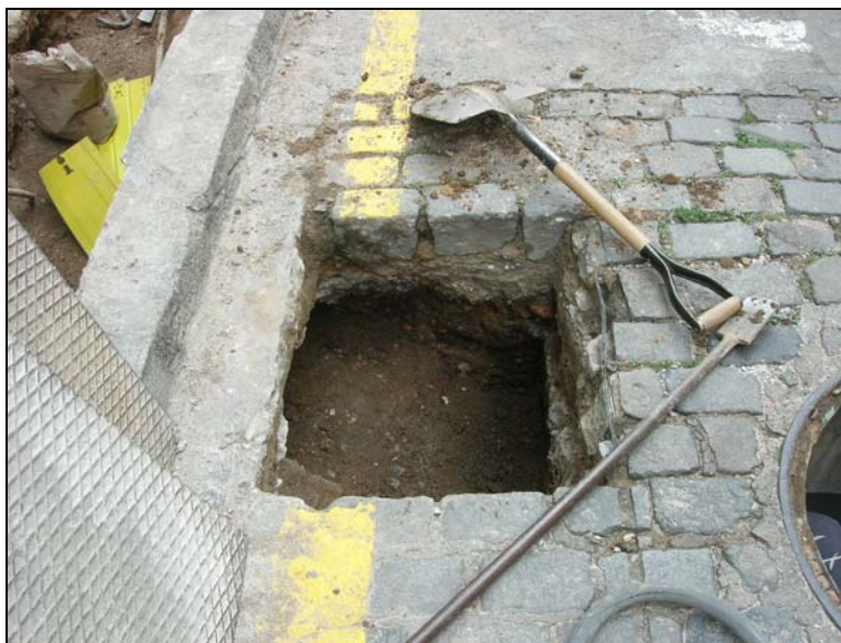
31. Cata per a connexió amb arqueta de la companyia Telefònica S.A, ubicada al centre del carrer Lluís el Piadós.
