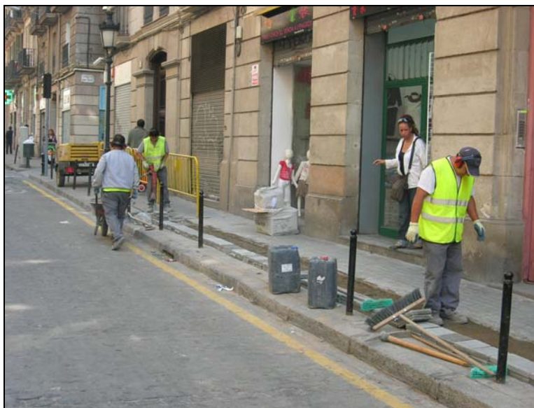
27. Tram final de la rasa.
