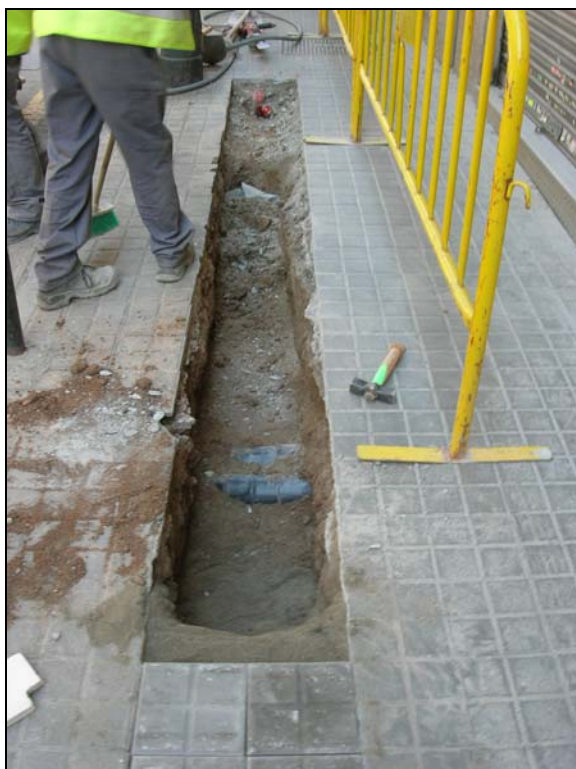
28 .Buidat final de la rasa.
