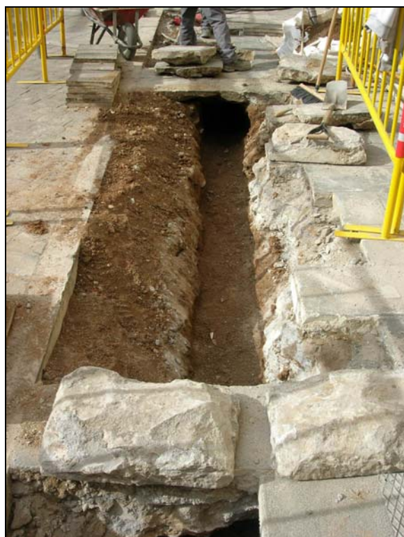
10. Vista del buidat de la rasa.
